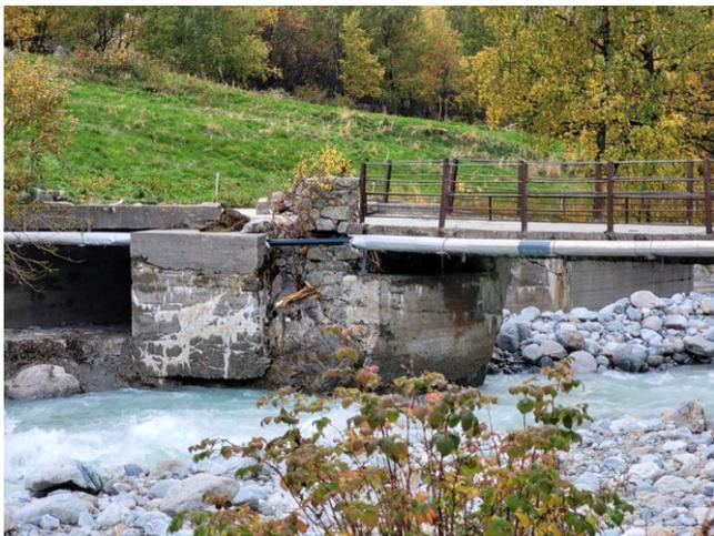
La crue d'octobre a endommagé l'isolation de la conduite d'eau, sa remise en état a été réalisée en urgence. Il faudra au printemps reprendre le mur amont du pont qui a été partiellement démoli.
